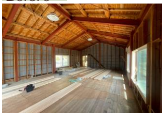
鉄筋倉庫の2階
